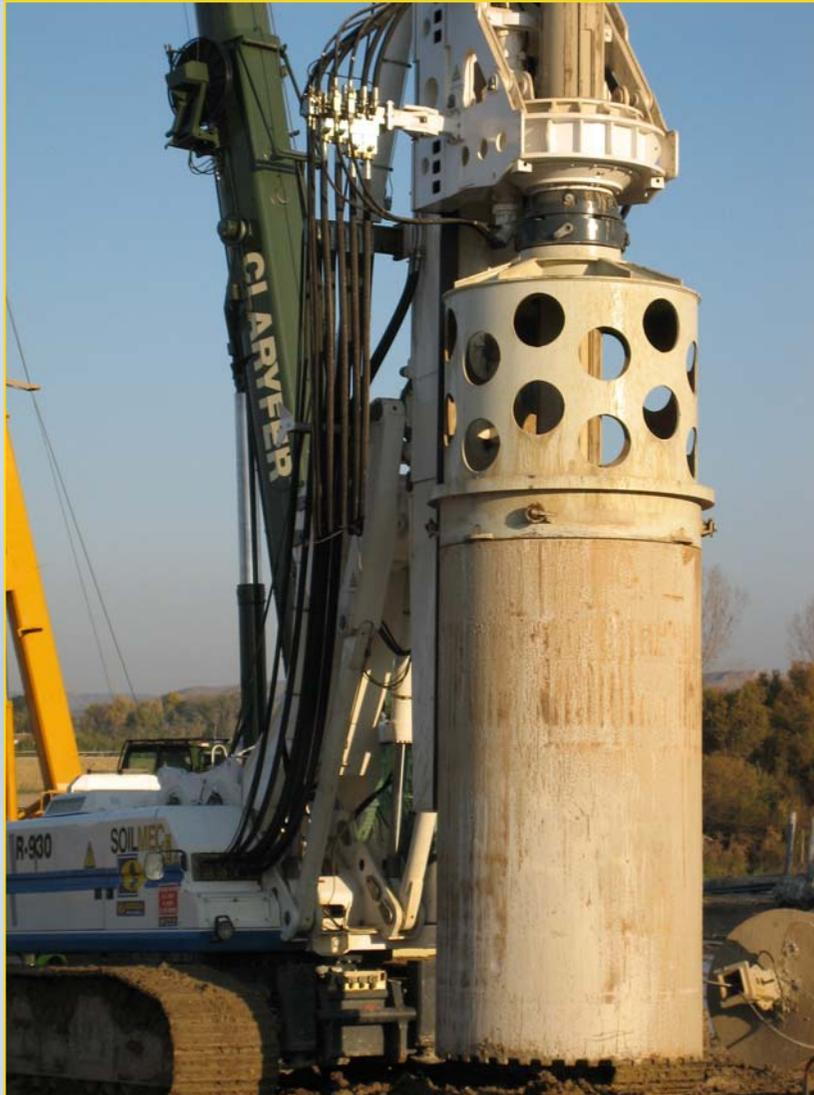
**Tubo zapata con la base dentada para facilitar la introducción en el terreno**
