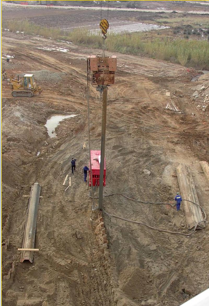
La hincas de las tablestacas se hace por medio de mazas de golpeo (lentas o rápidas, de simple o doble efecto), a presión o mediante aparatos vibradores adecuados.
