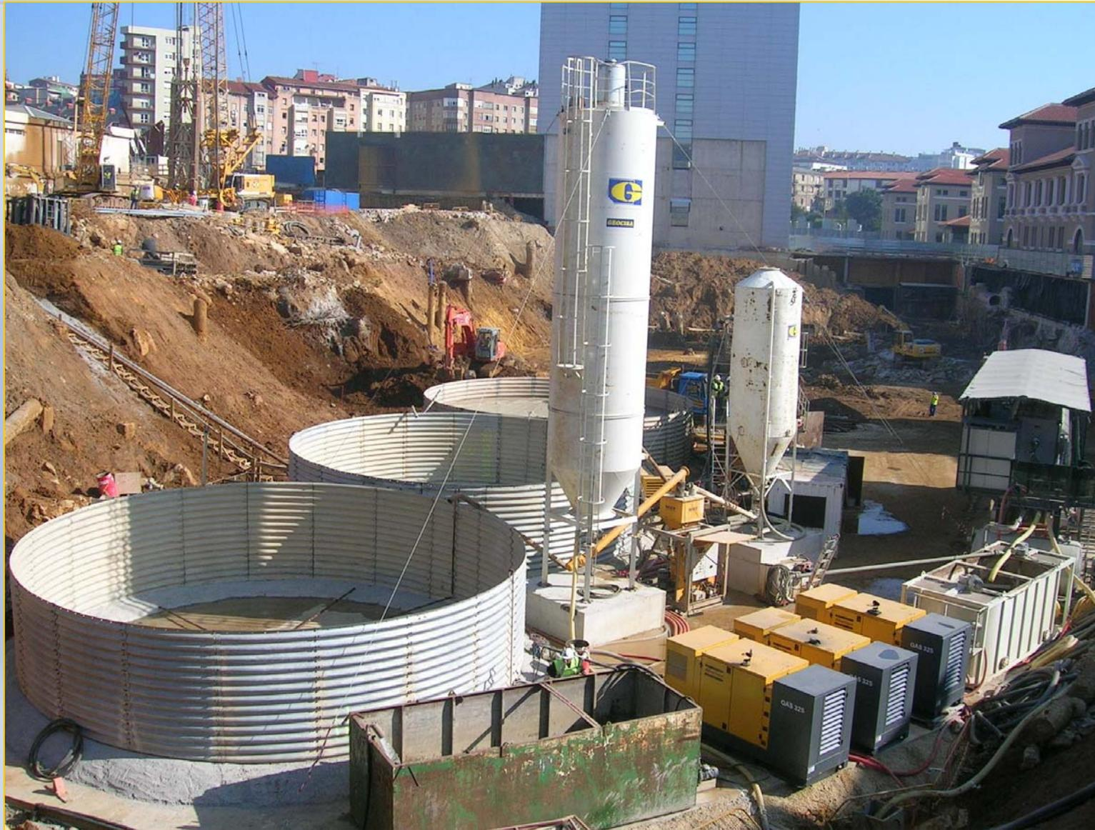
**Planta de lodos para hidrofresa**
