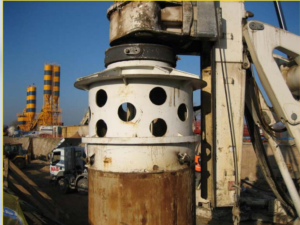
**Introducción de la entubación recuperable mediante la cabeza de rotación con campana de arrastre**
