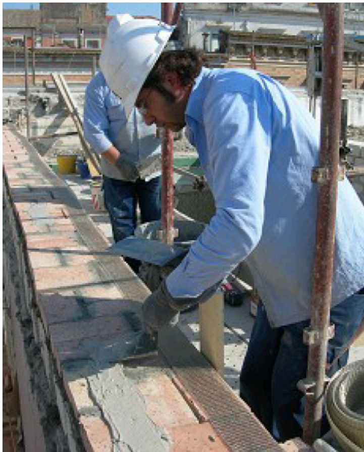
Colocación de la primera capa de Kimisteel LM
