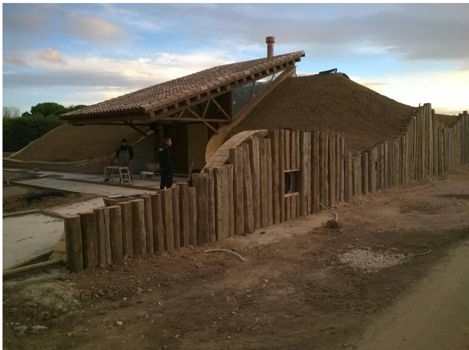
Foto en fase de ejecución.
