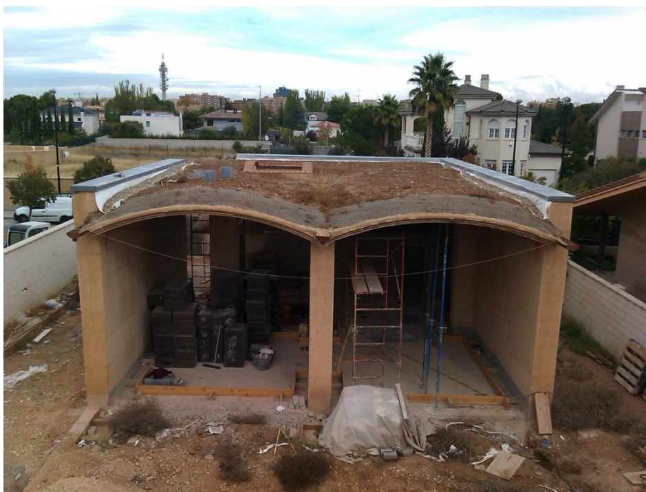
Foto del edificio en fase de ejecución.
