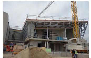
3 En las zonas de vuelo, los pilares metálicos se refuerzan con diagonales para absorber los esfuerzos generados.
