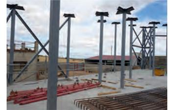
1 Los pilares metálicos apoyan en losas de hormigón armado, constituyendo de este modo la estructura del edificio.
