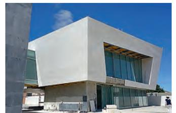
4 La piedra caliza blanca y el vidrio tratado con láminas técnicas de control térmico son los materiales principales con los que se ha construido la fachada.
